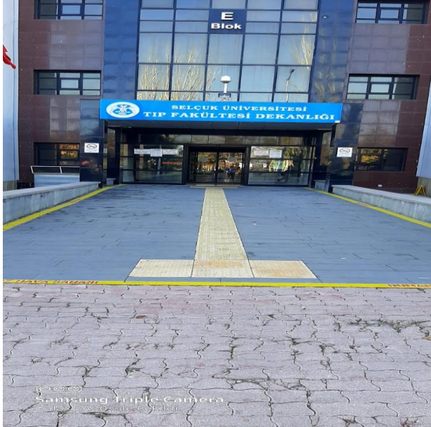
Şekil TS.7.1.7/3 Girişlerde Engelli yürüme bantı
